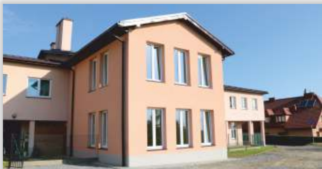
Dobudowana część szkoły
